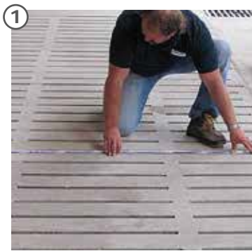
Spaltenboden wird vermessen
